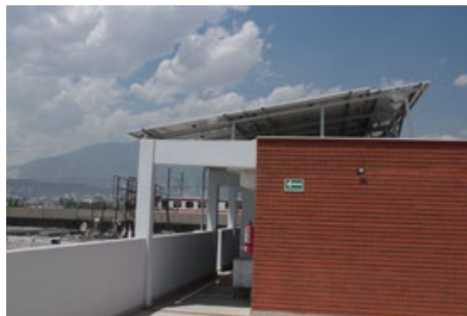
Donativo para equipamiento e instalación de paneles solares por Galt Energy.
